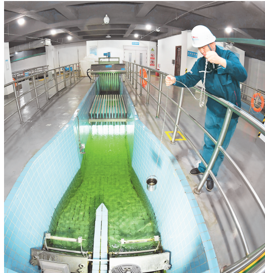
贵阳市青山再生水厂的工作人员从紫外消毒渠中取水作观感对比。 赵松 摄
