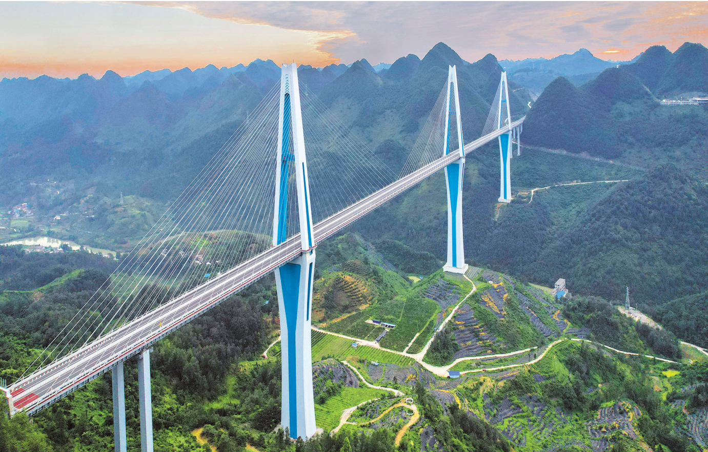
平塘特大桥，位于黔南平塘县，横跨槽渡河峡谷，全长2135米，主塔高332米（世界最高混凝土桥塔），为三塔双索面斜拉桥。
