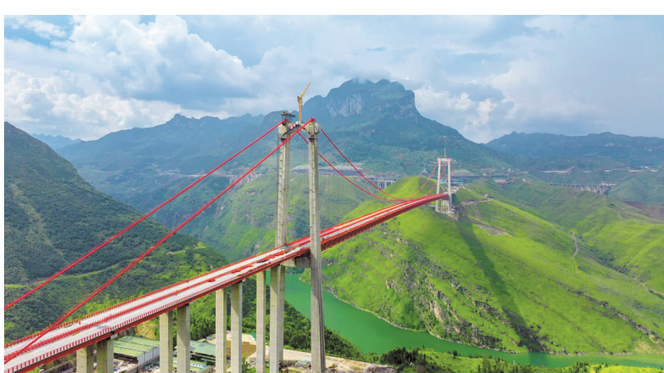
建设中的群荆江大桥。
