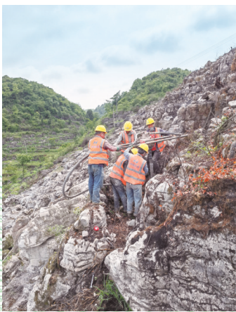
施工班组5人1组在石山上打地桩。(中核汇能贵州公司供图)
