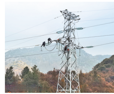
供电局工作人员正对输电线升级。
