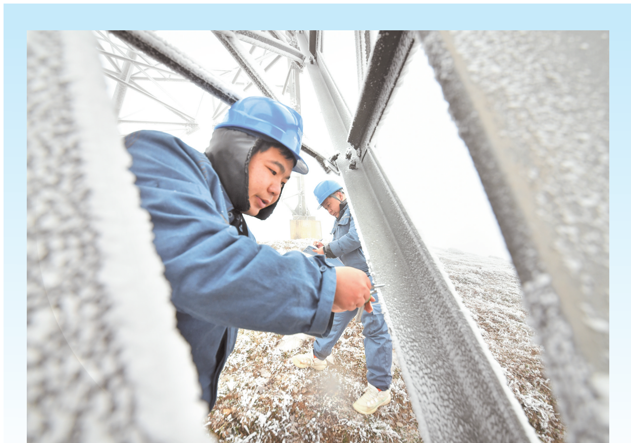
为保障居民冬季用电安全，12月16日，在毕节市威宁自治县盐仓镇，南方电网贵州毕节供电局输电管理所工作人员，对220千伏乌成线的导线和铁塔覆冰开展测量，做好输电线路覆冰危害防范。 罗凯 摄
