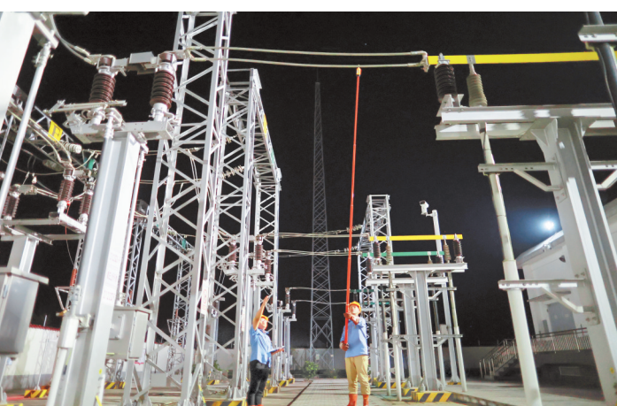
贵南高铁贵州段「通电」
