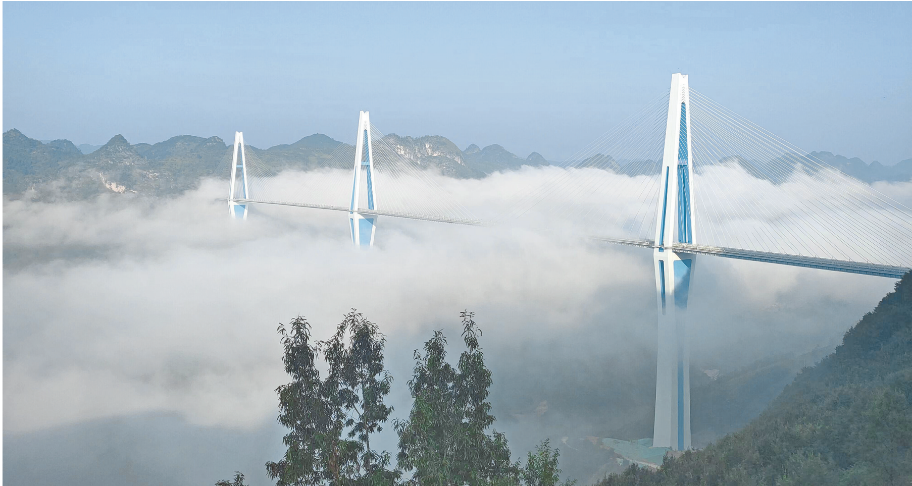
横跨千米槽渡河峡谷的“天空之桥”——平塘特大桥，中塔高达332米，是全球“最高混凝土桥塔”。（贵州图片库发）
