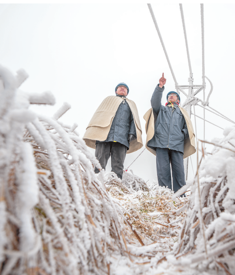
连日来,受持续低温天气影响,位于海拔2500多米的威宁自治县雪山镇灼草场变成了冰雪世界。威宁供电局雪山供电所的17名护电队员顶着风雪,开展巡线、除雪融冰工作,为辖区内群众的安全用电保驾护航。 罗大富 摄(贵州图片库发)
