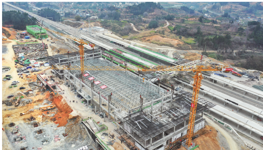
1月11日，由中铁建设集团承建的贵州高铁贵州段荔波站站台钢网架整体提升顺利完成。荔波站是贵州高铁贵州段新建最大车站，站房候车厅屋顶采用钢网架结构，网架最大跨度约为40.5米，当天钢网架合计提升重量约250吨。
