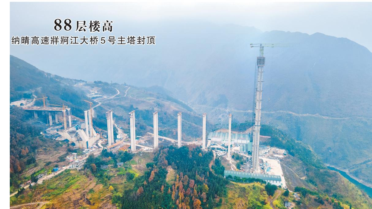
2022年12月31日，纳晴高速牂牁江大桥5号主塔顺利封顶，为大桥后续施工及纳晴高速如期建成通车奠定坚实基础。该桥位于晴隆县和普安县交界处，为主跨1080米的双塔单跨简支钢桁梁悬索桥，全长1849米，其中晴隆岸5号主塔高248.1米，相当于88层楼高。
