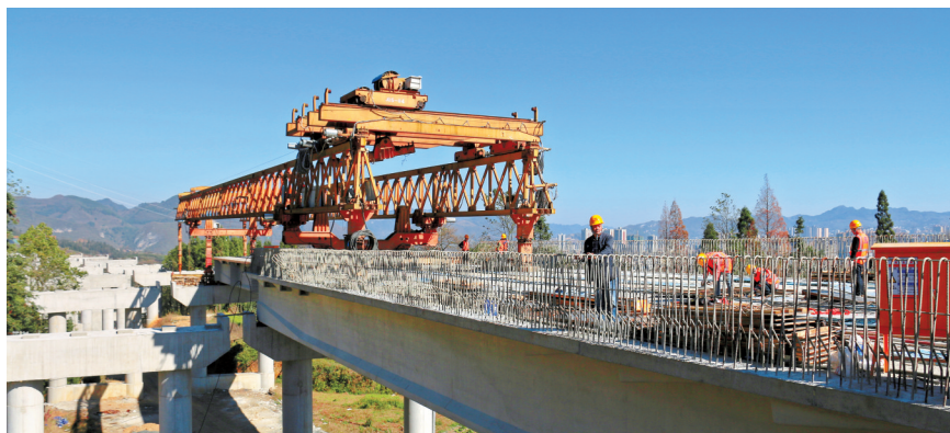
11月27日，纳晴（纳雍经六枝至晴隆）高速公路纳雍段建设现场一片繁忙，各参建单位利用晴好天气，抢抓工程建设进度。纳晴高速纳雍段全长30公里，设计时速100公里。目前，纳雍段已完成计划进度的55%。项目建成投用后，使得沿线的纳雍、织金、六枝、晴隆以及黔西南州的南北向交通联系更加方便、快捷。 杨英 摄（贵州图片库发）
