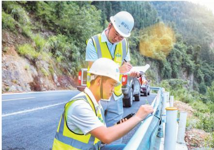
弘景公司技术人员对波形护栏涂层厚度进行检测。
