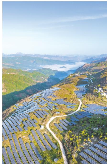
4月，进入光照更充足的季节。六特特区月亮河乡老虎坪光伏项目负责人介绍，目前是光伏发电的黄金期，日常检修维护非常重要。老虎坪的光伏电站通过110千伏郎岱变电站并入南方电网，每年为电网提供9万兆瓦时清洁能源。
