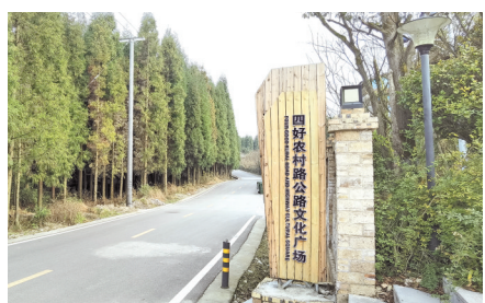
改变了的靛山村公路。
