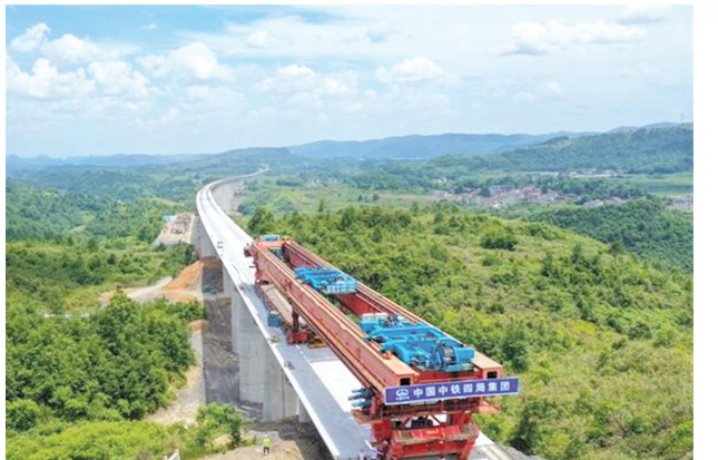
银坡河双线特大桥顺利合龙。
