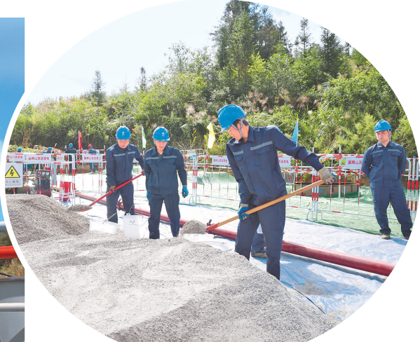
↑藏粤直流工程滇14标G017塔首基基础试点现场，施工人员严格按照配合比精准实施配料和拌合。（天生桥局供图）
