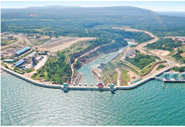
↑ 航拍视角下的朱利叶斯·尼雷尔水电站。
