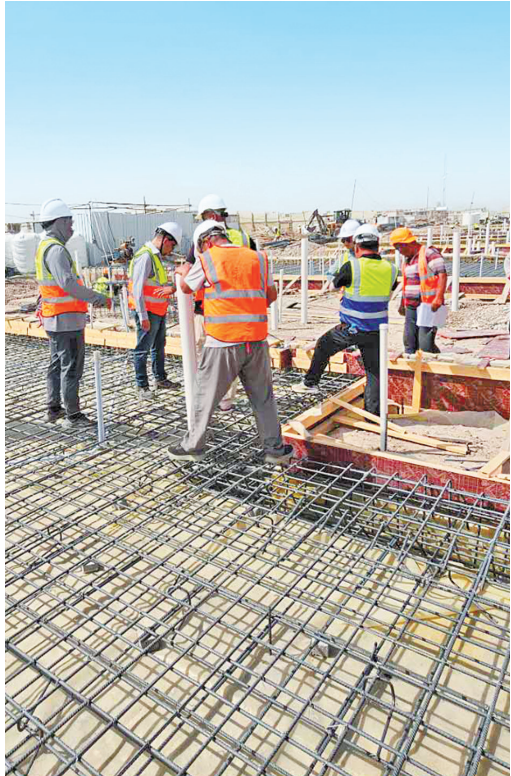
中国电建集团贵阳勘测设计研究院有限公司中东北非分公司伊拉克项目施工现场。
