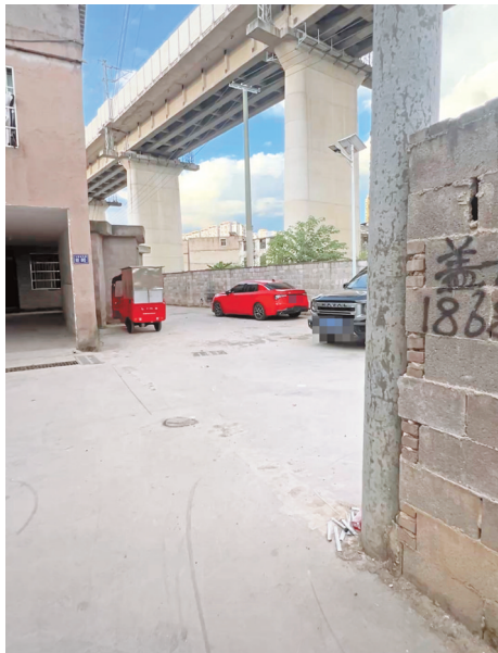
小广场被打开了缺口，有私家车停入。
