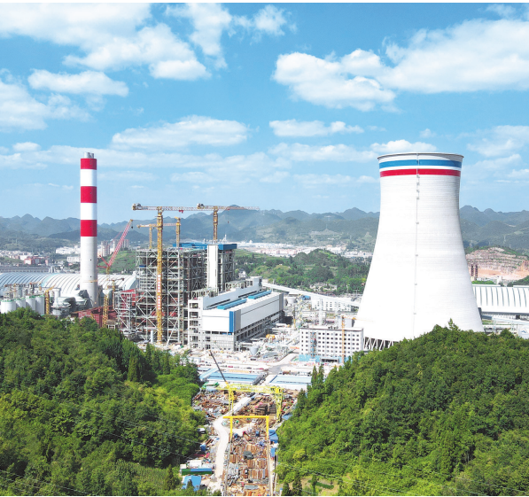
贵州能源水城2×66万千瓦燃煤发电项目。
