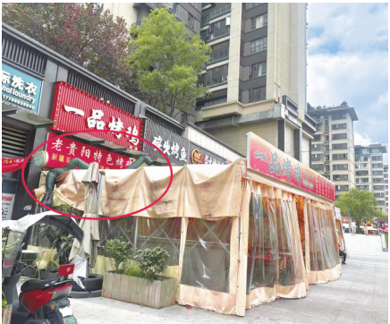
贵阳市融创九樾府小区底层商铺油烟直排（摄于8月10日）。
