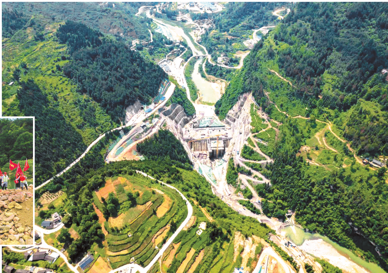
铜仁市花滩子水库建设现场航拍。
