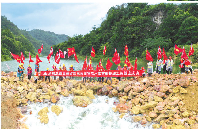
黔东南州宣成水库工程截流现场。
