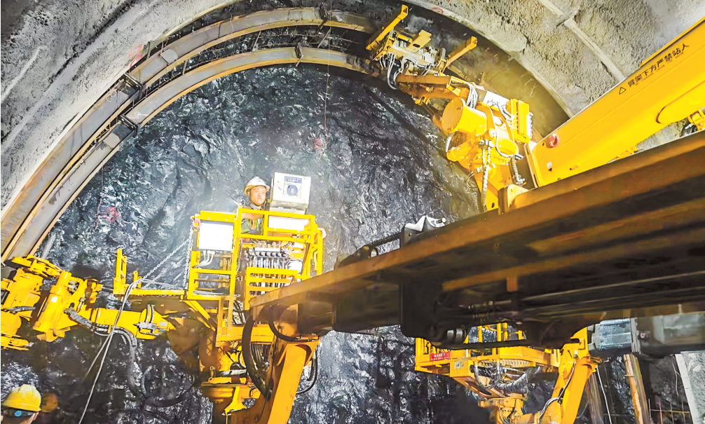
拱架安装台车作业中。 秦渔焱 摄
