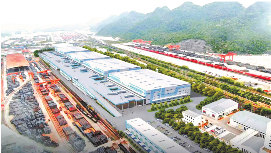
鸟瞰牛郎关智慧物流园，连片仓储厂房与货运通道纵横交织，各类货物在此高效集散转运。（贵州现代枢纽物流运营集团有限公司供图）
