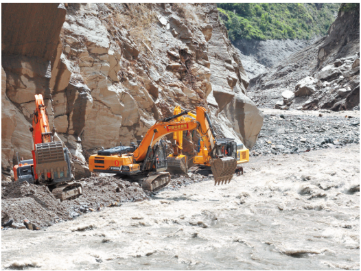
8月29日，应急管理部调派中国安能工程力量持续对G216国道损毁路段全力开展抢通作业。
