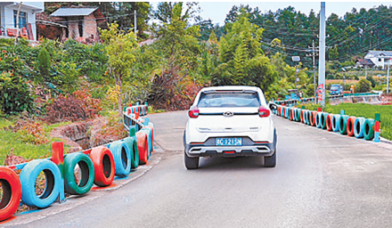
废旧轮胎在道路两侧布设起柔性护栏。
