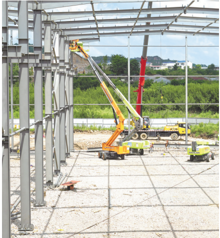
安顺航空配套制造产业园三期项目建设快速推进中。 本报记者 杨曦 摄
