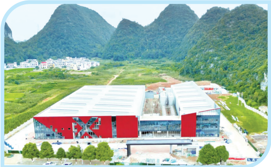
贵州焯烽酿造科技生物饮品生产基地一期厂房建设已经完成。 本报记者 沈长志 摄
