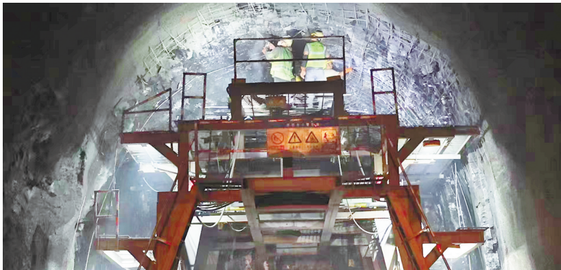
施工人员在拉乌隧道作业。
