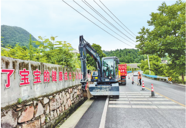
习水公路段对边沟进行清理。
