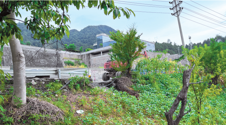
跨国道改造安装排水管。
