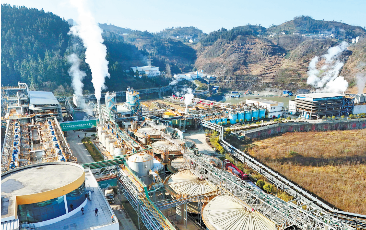
贵州紫金金矿选冶工厂运用新工艺提高难选冶金矿的金浸出率，图为厂区一角。
