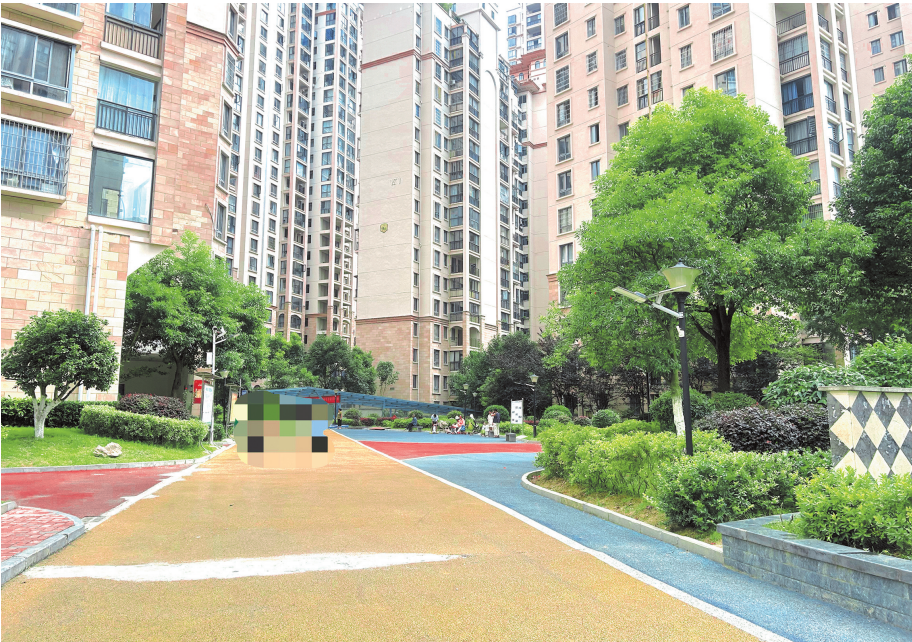
黔西市水西半岛小区。
