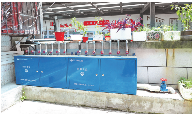
小区楼栋外墙处，供水管道铺设完毕。
