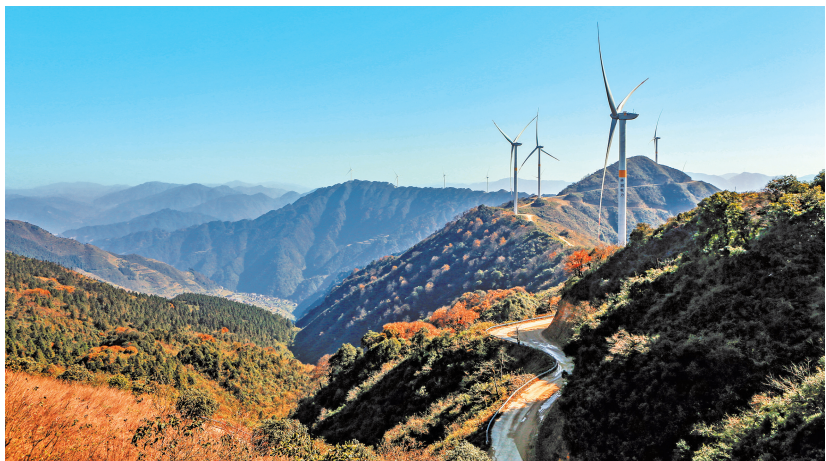
剑河县新能源设施。(剑河县委文联供图)
