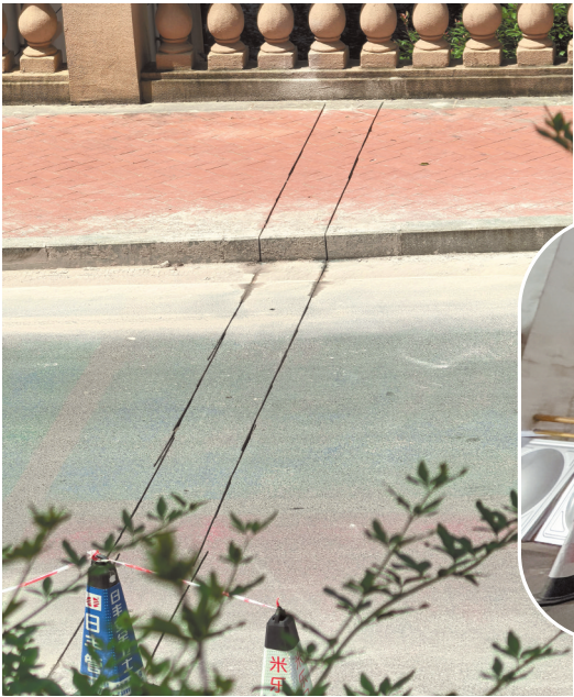
←小区内部道路已切割完毕，为后续接入新增管道作准备。
