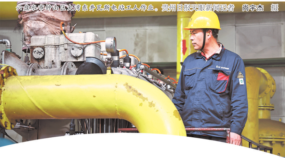
六盘水市钟山区大湾东井瓦斯电站工人作业。贵州日报天眼新闻记者 尚宇杰 摄
