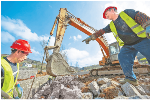
毕节市大方县瓢井镇高标准农田施工现场。邓钺洁 摄
