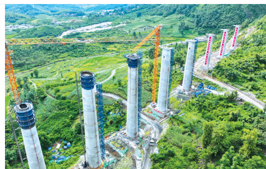
中铁二十三局承建的黄百铁路羊架河特大桥建设现场。
