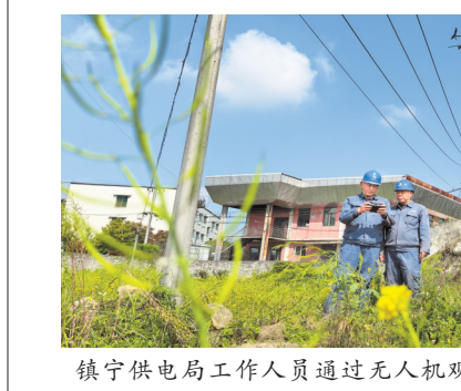
镇宁供电局工作人员通过无人机观测山火隐患点。
