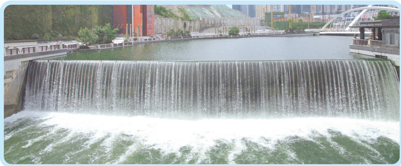
由贵州水利院负责设计的贵阳市南明河综合治理工程——气动盾形水闸。（贵州水利院供图）
