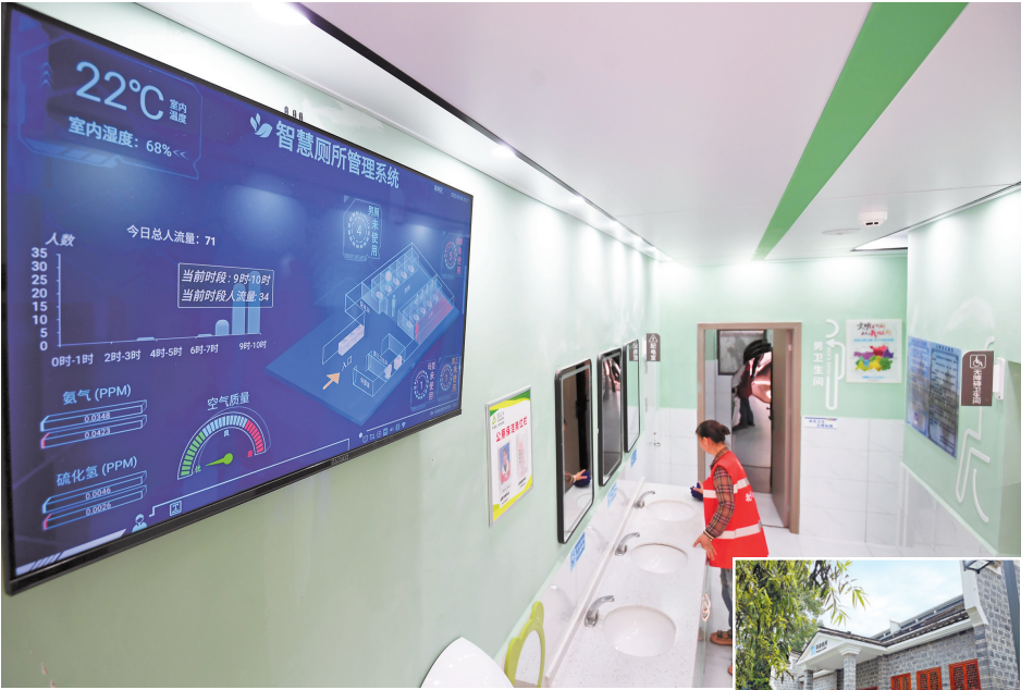
贵阳市南明区箭道街公厕，智慧厕所管理系统和智能监测系统对空气质量指标实时监测。一旦指标超标，香气系统将自动启动，及时改善空气质量。
