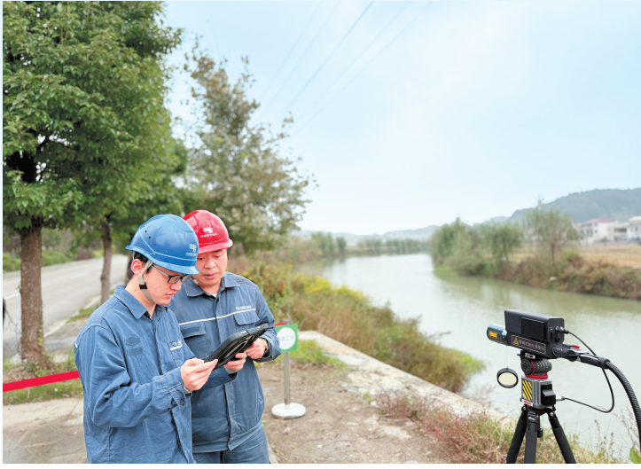
平坝供电局工作人员手持智能平板，远程操控激光清障设备。
