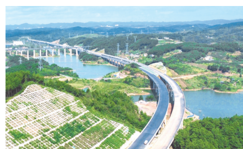
中铁贵州工程有限公司承建的乌长高速公路TJ-2标项目桃源河大桥段。
