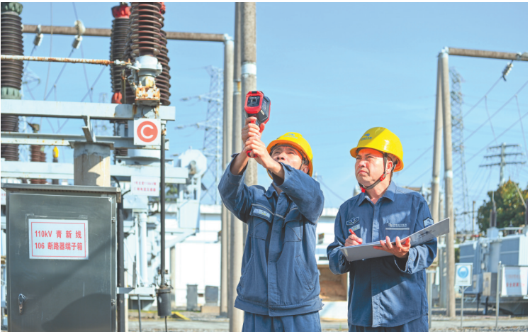
10月4日，南方电网贵州凯里供电局岑巩运维中心工作人员，对110千伏新兴变电站的设备开展红外外测温，掌握设备运行健康状况，确保国庆中秋长假电网安全稳定运行。杨启志 摄（影像贵州）
