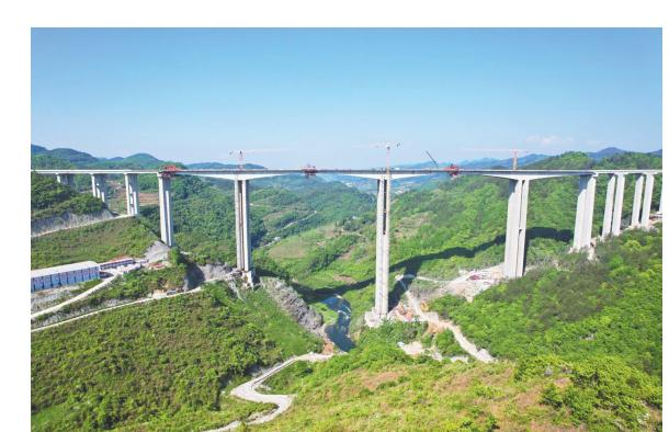
4月28日，由贵州公路集团承建的贵（阳）平（塘）高速公路南明河特大桥顺利实现合龙。南明河特大桥是贵平高速的控制性工程之一，为多跨连续刚构桥，全长1129.8米。
